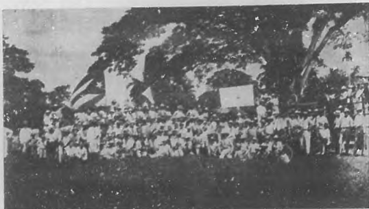
El alcalde de Barrio de Majagua, varios candidatos a concejales y consejeros, y numerosos habitantes de esa población, en los momentos en que se disponían a partir, para comenzar los trabajos de construcción del camino de Majagua a Marroquín.
