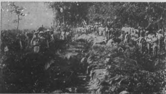
Los ciudadanos que se han prestado a construir el camino de Majagua a Marroquín, durante un alto en sus rudas y desinteresadas labores.
